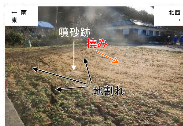
地割れ・噴砂跡※等の状況（断層中央部付近）
