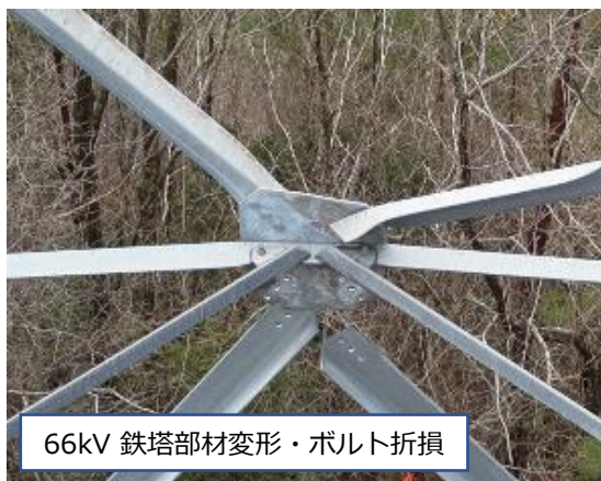
66kV 鉄塔主材変形
