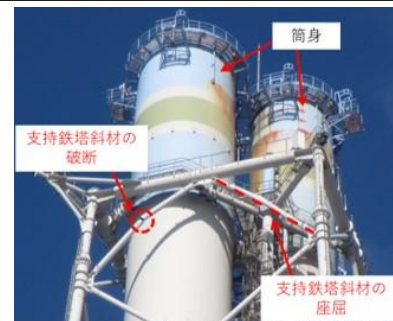
煙突支持鉄塔斜材が座屈・破断 ⇒補修作業中
