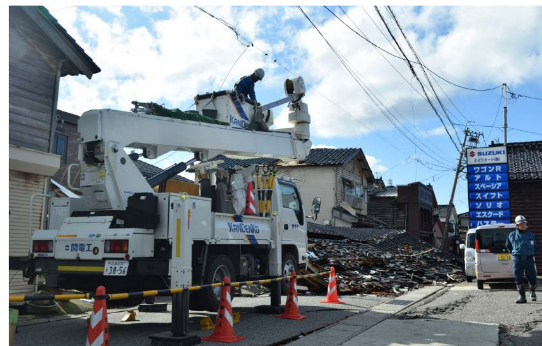
輪島市河井町で復旧に臨む他社応援の工事会社
