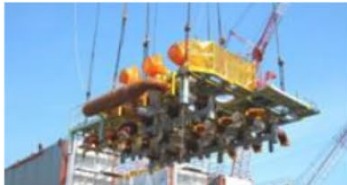
ABWRの高圧ドレンポンプ配管・弁室モジュール
