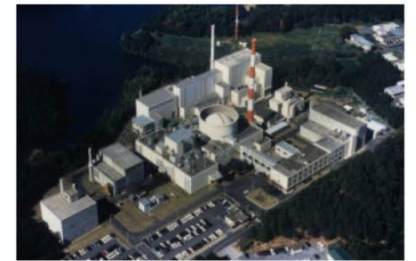
常陽・照射後試験施設
